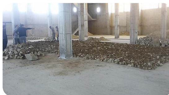
شکل ۷- آماده‌سازی نمونه‌های برداشتی و دسته‌بندی آنها
